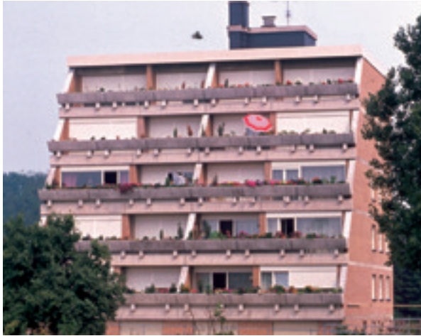
Terrassenhaus in der Kneippstraße 9
