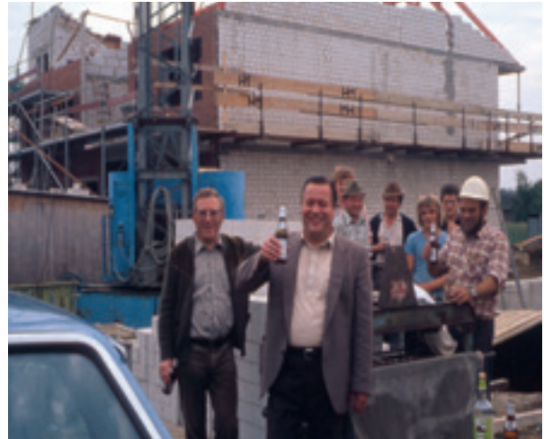
Richtfest für die Häuser am Grünen Weg
